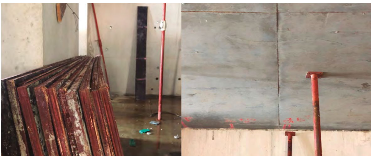
Falsche Plattenabstützung
